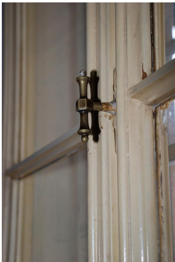
1702. Přízemí (1.N.P.), místnost č. OP39, okno v jižní stěně – detail olivy.
