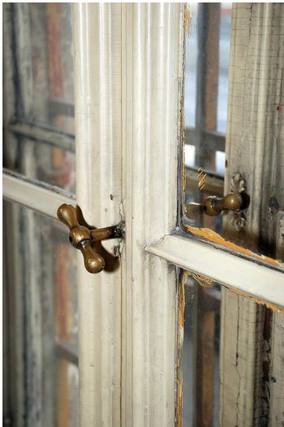
1700. Přízemí (1.N.P.), místnost č. OP38, okno v jižní stěně – detail olivy.
