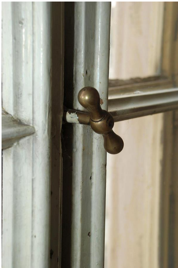
1696. Přízemí (1.N.P.), místnost č. OP36, okno v jižní stěně – detail olivy.
