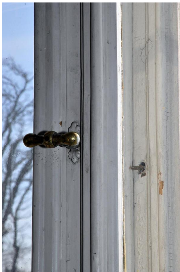
1642. Přízemí (1.N.P.), místnost č. OP09, levé okno – detail olivy.
