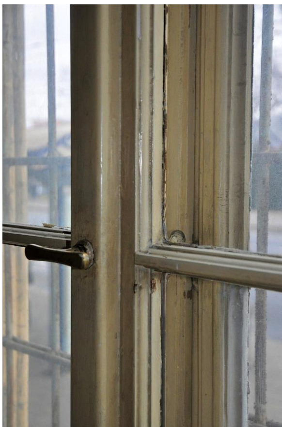
1768. Přízemí (1.N.P.), místnost č. OP125, okno v jižní stěně – detail olivy.
