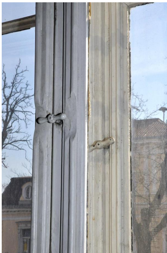
1644. Přízemí (1.N.P.), místnost č. OP09, pravé okno – detail olivy.
