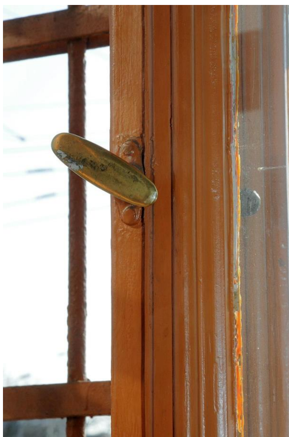
1775. Přízemí (1.N.P.), místnost č. OP144, okno v jižní stěně – detail olivy.
