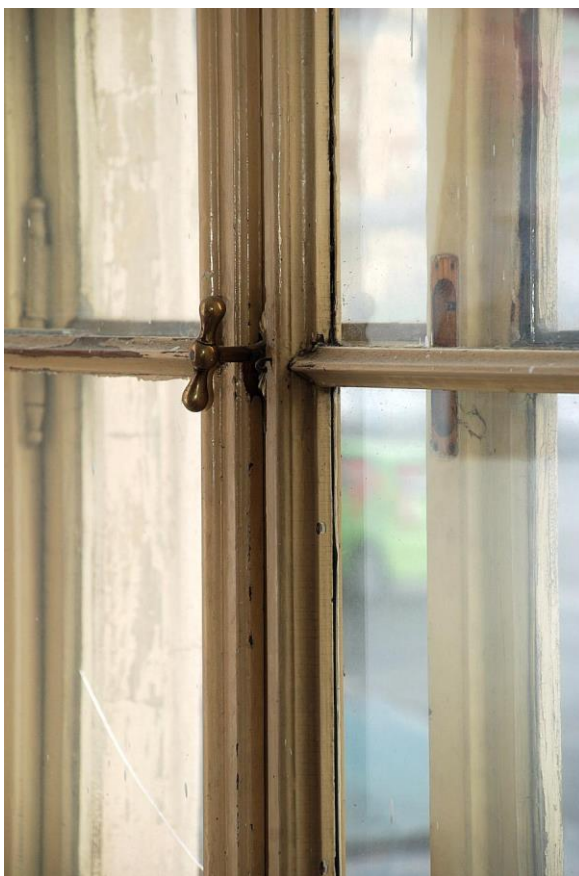
1682. Přízemí (1.N.P.), místnost č. OP33, okno v jižní stěně – detail olivy.
